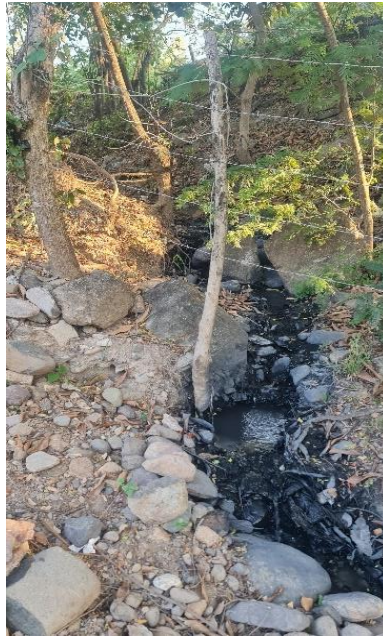
Figura 31: flujo de la descarga hacia el Río Calderas, a través de desagüe subterráneo hacia el Río Calderas.
