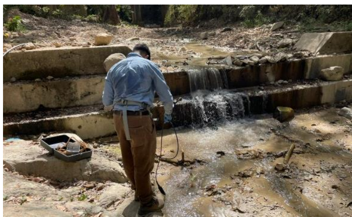
Figura 27: presa para retención de sedimentos en San Juan Arriba (SM-062).
