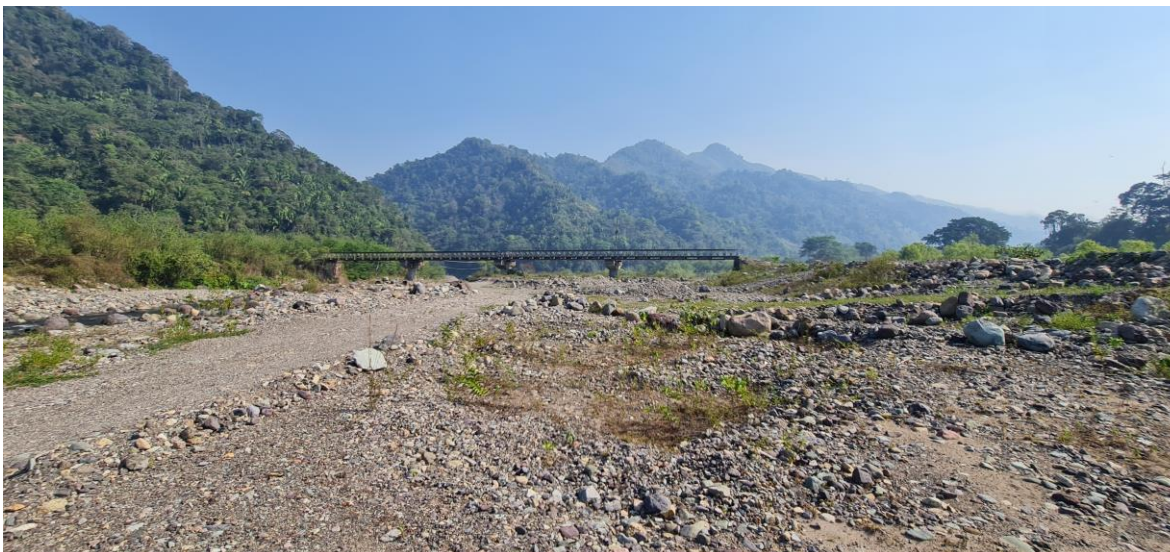
Ilustración 6 Puente Bailey a la altura de Río Viejo
