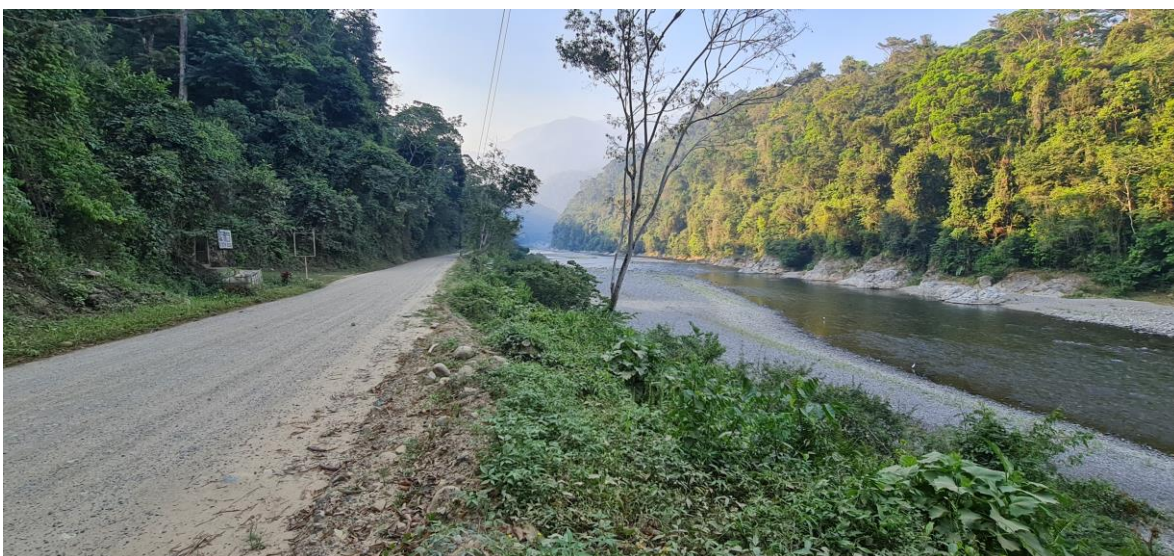
Ilustración 8 Calle de acceso, paralela al cauce del río, sin borda de contención
