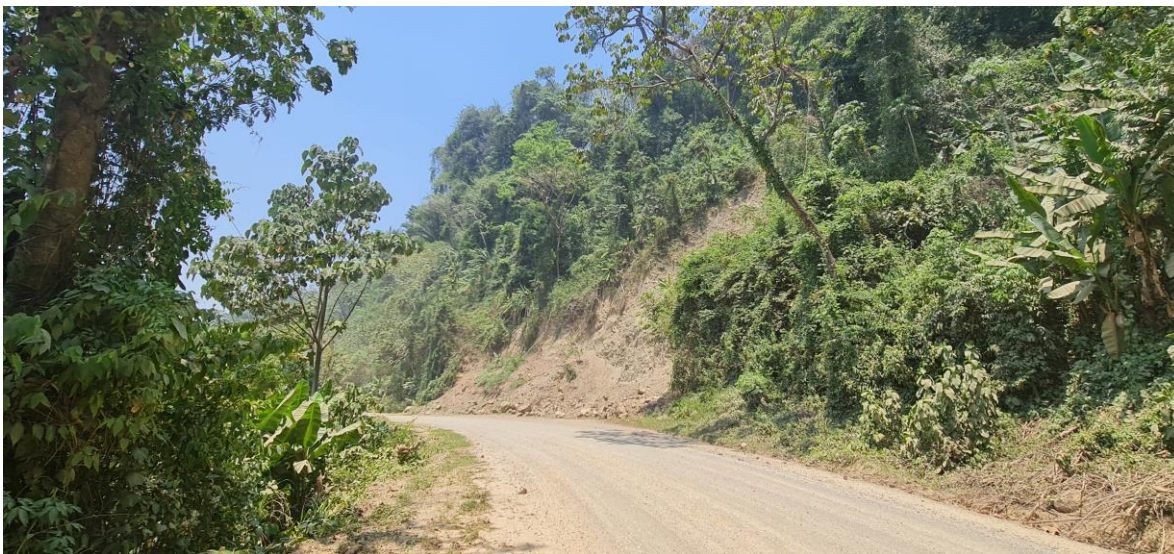
Ilustración 9 Derrumbe en calle de acceso
