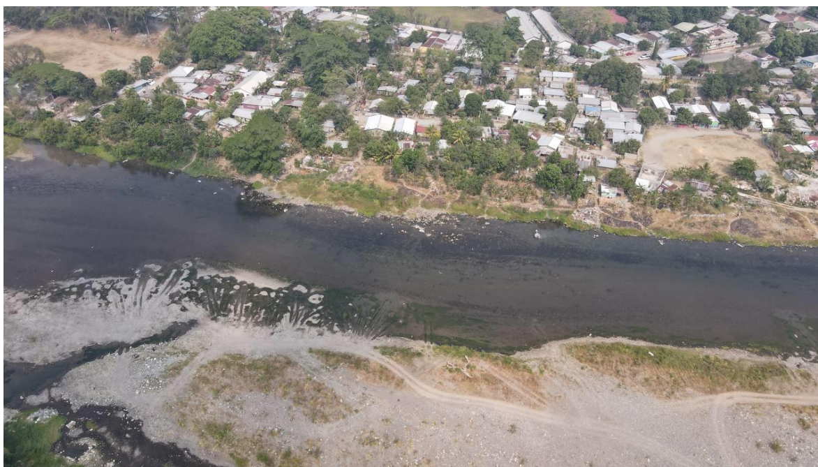
Ilustración 13 Viviendas establecidas en el cauce del río
