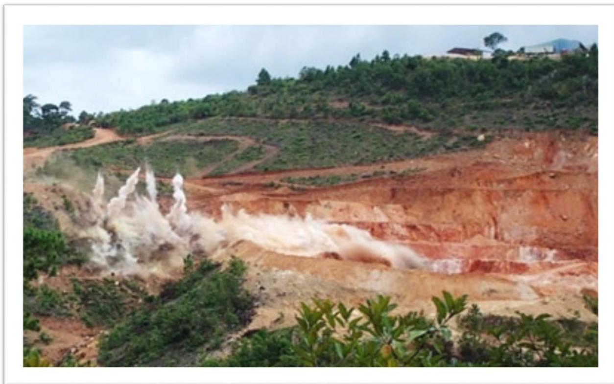
Ilustración 9: Eliminación por explosión de la cobertura vegetal en una mina a cielo abierto.
