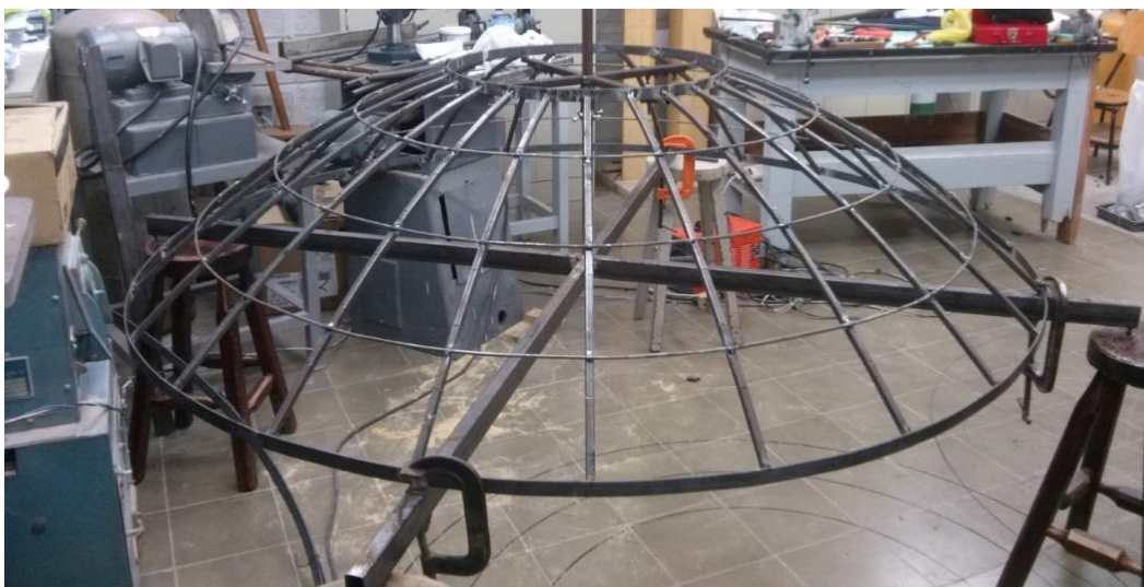
Con el ingeniero Francisco Montes en la construcción del Concentrador Solar
