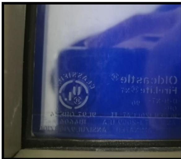
*Nota. Etiqueta de certificación que muestra que el vidrio está construido para una instalación de categoría II que corresponde a una instalación con equipo de radiodiagnóstico.*
